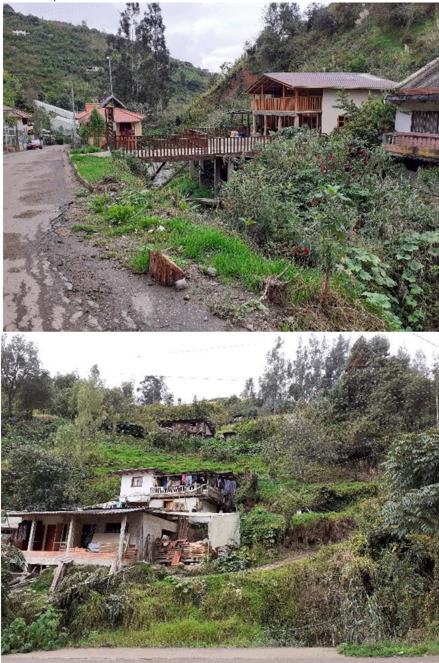
Foto 28: Viviendas emplazadas en suelo no urbanizable.
