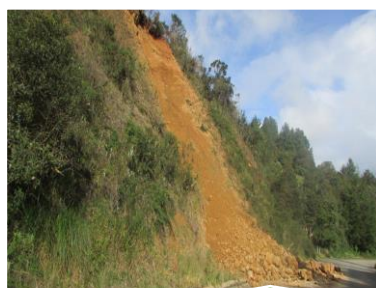
Derrumbe 1 Sector Canal.
