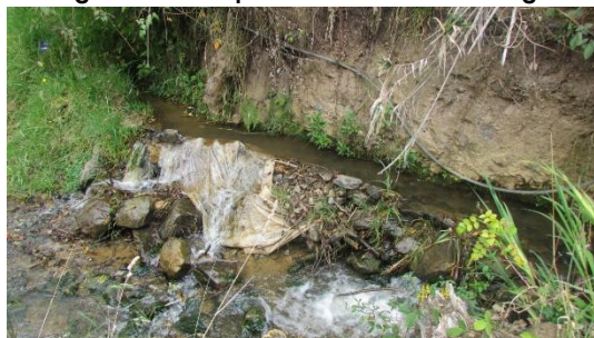
Fotografía 2.5.3 Captación del sistema de riego
