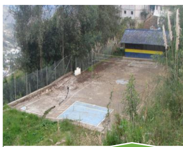
Falla geológica 1. Sector Tambillo
