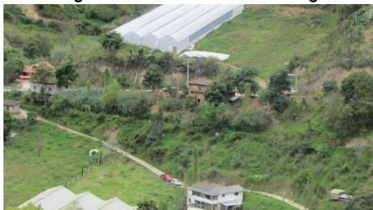
Fotografía 2.5.2 Tramo dEl Canal de riego
