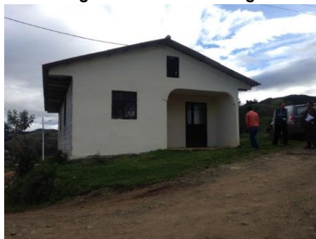
Fotografía 2.2.26 Junta de agua
