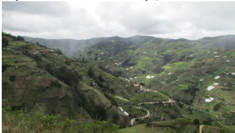
Fotografía 2.1.22 Alteración de los cursos naturales del agua por la construcción de las vías.
