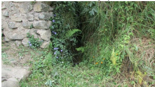
Fotografía 2.5.4 Desgue del sistema de riego, junto a la vía Paute Bulán
